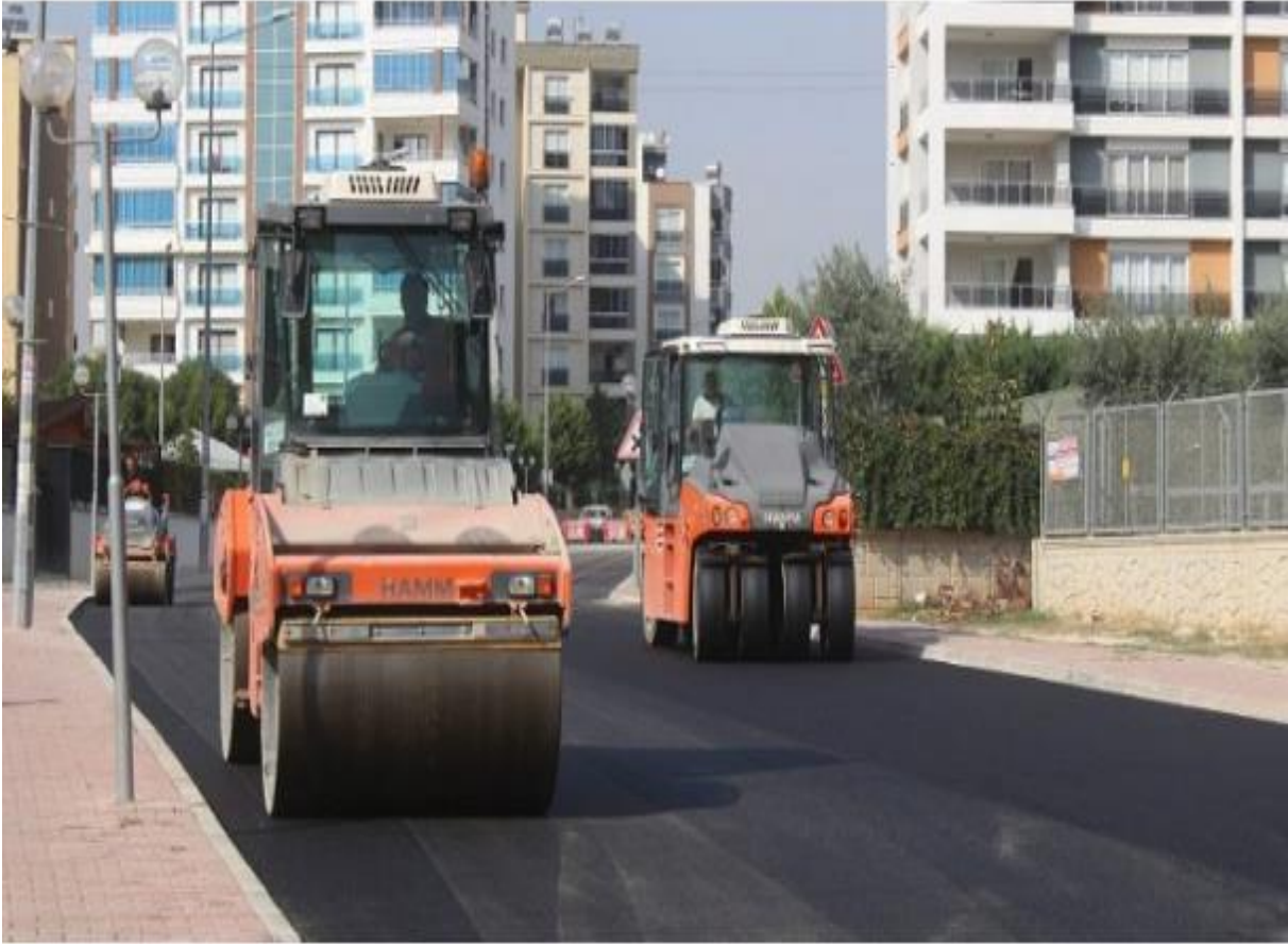
OKAN MERZECİ MAHALLESİ YOL ÇALIŞMASI TAMAMLANDI
