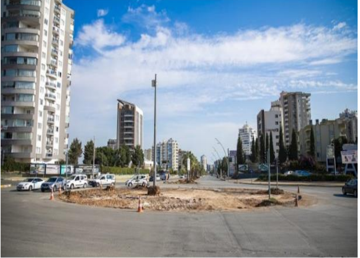
İKİNCİ KANALİZE KAVŞAK ÇALIŞMASI BAŞLIYOR
